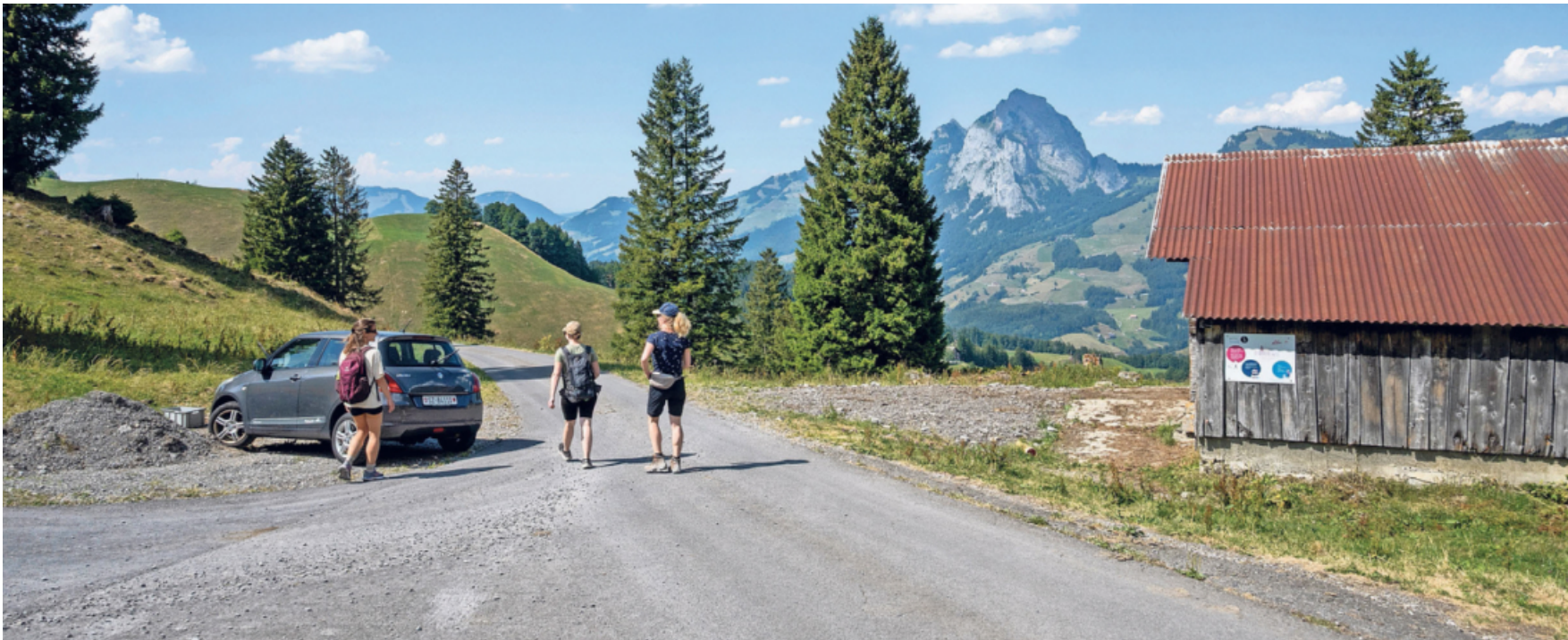
Beim Brunnerboden auf dem Stoos beginnt der asphaltierte Teil der Stoosstrasse. Dieser Teil ist in einem guten Zustand und erschliesst diverse «Heimetli». Mit einer Tagesfahrbewilligung der Flurgenossenschaft darf die Stoosstrasse befahren werden. Bild: Erhard Gick
